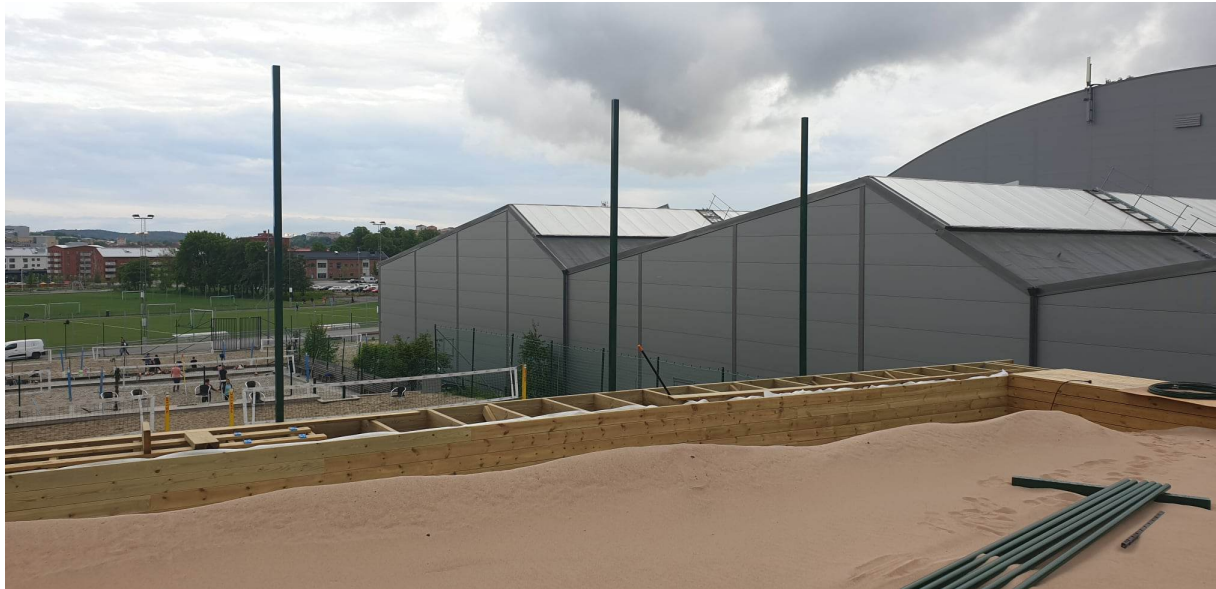
Fyra nya utomhusbanor på en fjärde etage nivå byggdes under våren 2022
